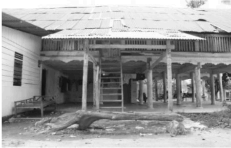
Gambar 4. Posisi Tangga di rumah
