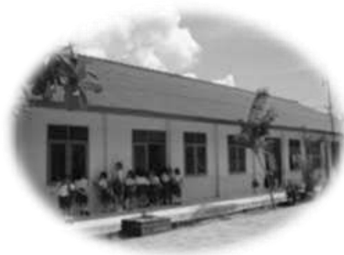
Foto : Gedung Sekolah Dasar
