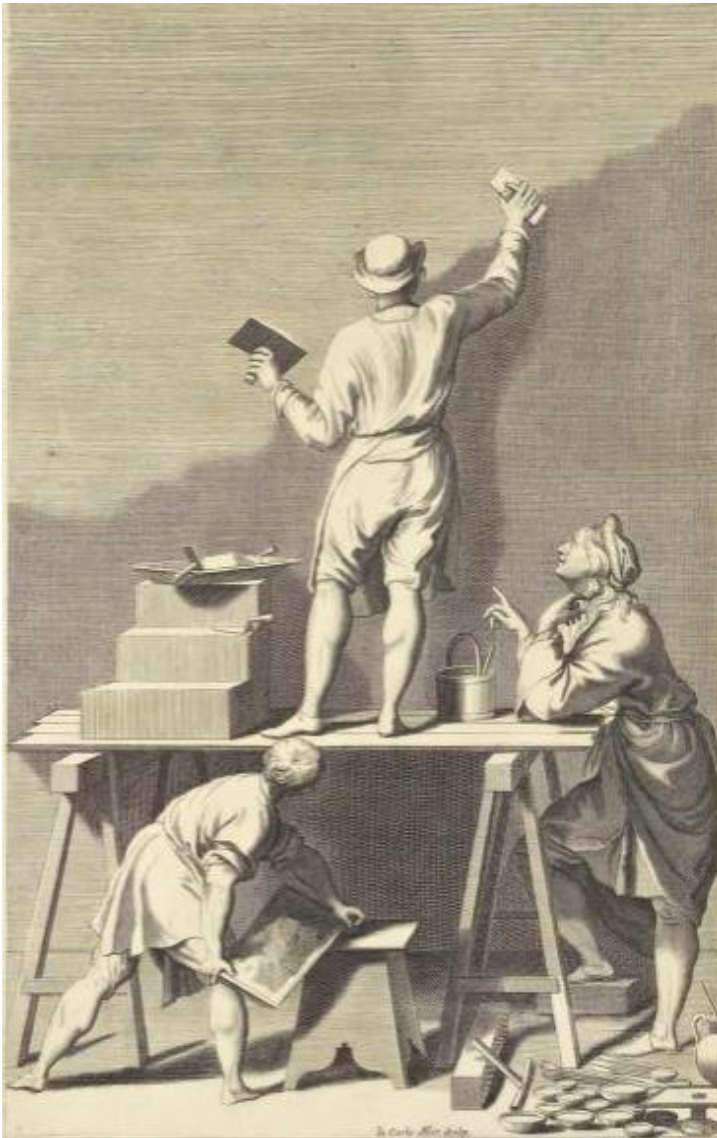
Gambar 2.90 Mempersiapkan dinding untuk Lukisan Fresco (Pozzo).
