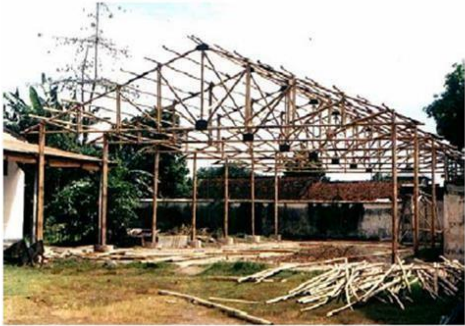
Gambar 16. Konstruksi kuda-kuda Bambu (Sumber: Morisco, 1999)
