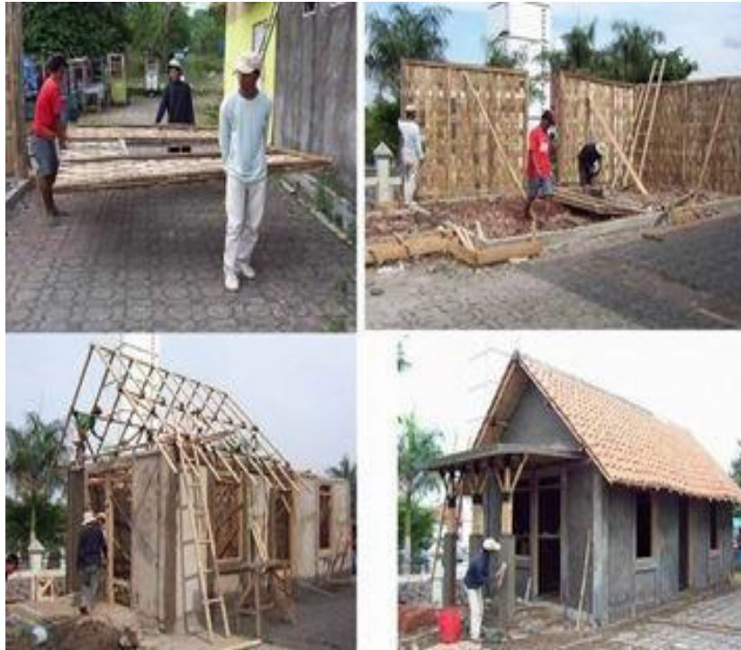
Gambar 11. Proses pembangunan bambu plester (Sumber : Dokumentasi Bpk. Andry Widyowijatnoko dan Mustakim)
