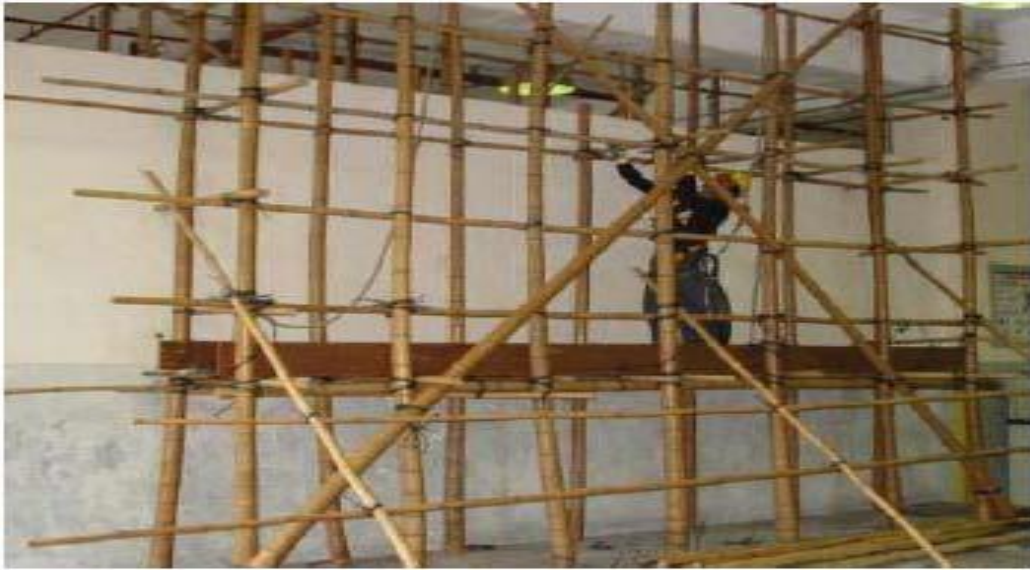
Gambar 2. Bambu untuk scaffolding (Chu, 2002).
