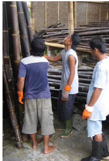
Gambar Pengisian Larutan untuk Gambar 5 Pengisian Larutan untuk Peredaman Vertikal Bambu
