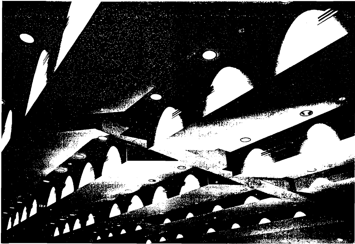
Gambar 6.12 Pengaturan panel langit-langit pemantul bunyi yang bergerigi, yang menyebabkan difusi yang menguntungkan dalam ruang kuliah dengan 300 tempat duduk, di Universiti de Montreal. (Beauvais dan Lusignan, arsitek; L.L. Doelle, konsultan akustik. Foto oleh Studio Bowe.)
