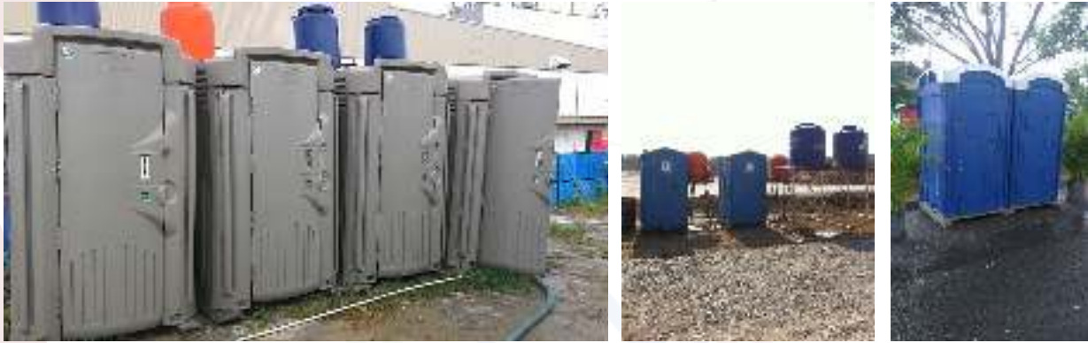
Foto Toilet VVIP di Proyek Essence lokasi Cikarang
