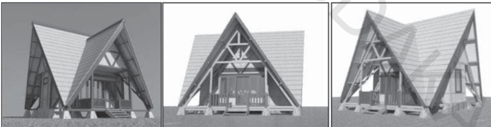
Gambar 8.5. Modifikasi bentuk atap jolopong pada rumah ramah gempa di Desa Jayapura, Kecamatan Cigalontang-Tasikmalaya.
